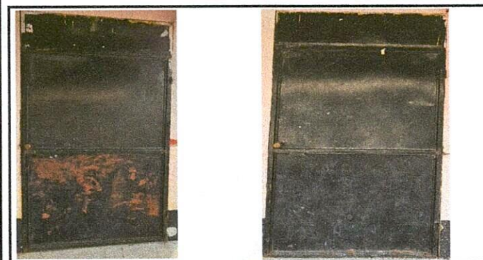
Foto 5: cambio de puertas de metal por metal
