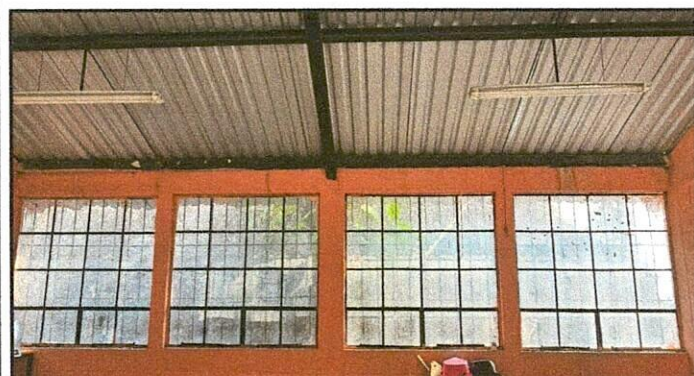
Foto 3: Mejoramiento de ventajas, corredizos,
