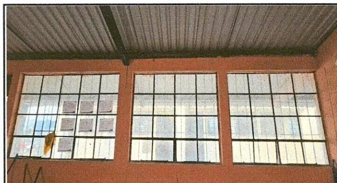
Foto 4: mejoramiento de ventanas corredizos
