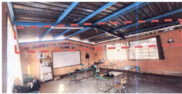
Foto 9: Vista interior del modulo 1, se realizara la colocación de hiladas de block, actualmente este espacio se introduce el polvo, la cual afecta a los niños que reciben las clases.
