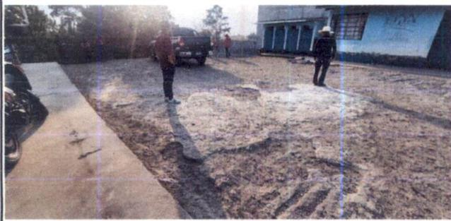
Foto 7: Vista del patio, el cual se remozará, con torta de concreto de 10 centímetros.
