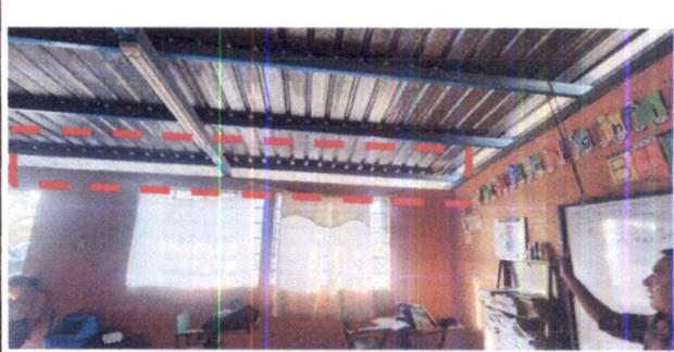
Foto 8: Vista interior del modulo 1, se realizara la colocación de hiladas de block, actualmente este espacio se introduce el polvo, la cual afecta a los niños que reciben las clases.
