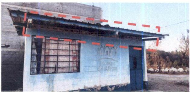
Foto 11: Vista de la cocina, se realizara la colocación de hiladas de block, actualmente hay block sobre puesto, peligroso ya que puede caerse.
