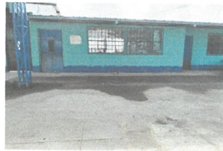
pintado de paredes
