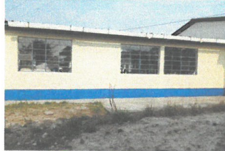
vista de ventanas sin balcón.
