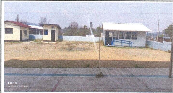
Foto 1: Área de trabajo por sustitución de suelo por torta de cemento
