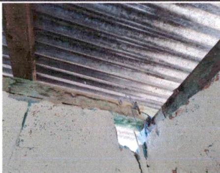
Foto 11: Vista de cubierta de lamina y del anclaje existente, los cuales están en mal estado.
