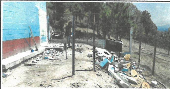
Foto 3: Inicio de remodelación de servicios sanitarios .
