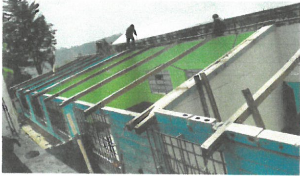
Foto 3: Desmantelación de entechado .
