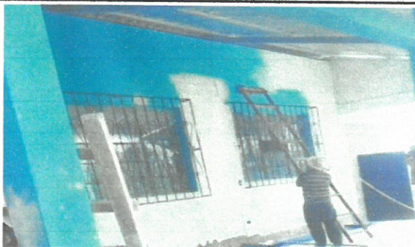
Foto 3: Inicio de pintura de paredes externas.
