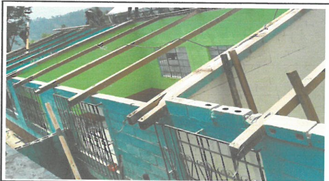
Foto 2: Pintura de paredes internas anteriormente.
