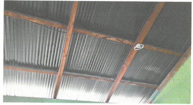
Foto 2: imágenes interna de las aulas antes del remozamiento
