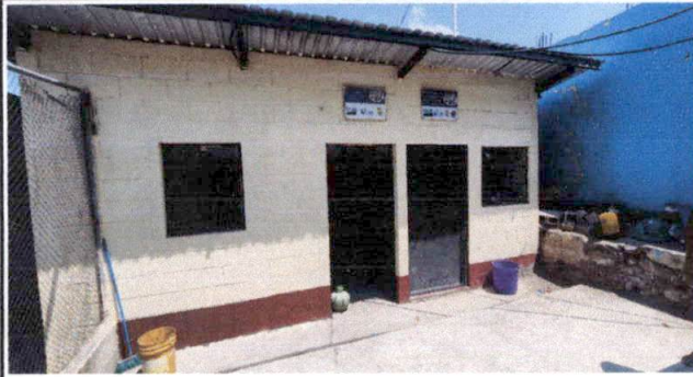
Foto 7: Vista de la cocina, se observan las ventanas donde se colocaran balcones metálicos, debido a la inseguridad del lugar.
