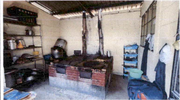
Foto 8: Vista interior de la cocina, se observa la estufa mejorada la cual se remozará, cambiando ladrillos y tubería de la chimenea.
