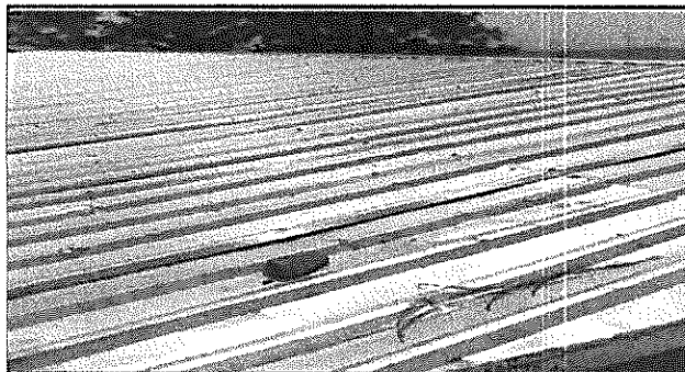
Foto 5: Sustitución de láminas en mal estado.
