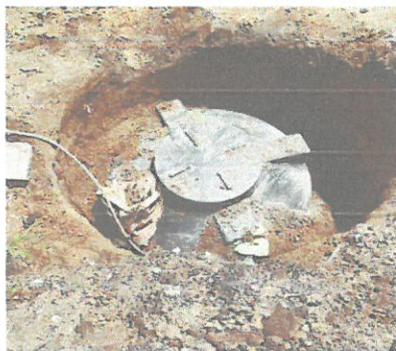
Foto 5: Instalacion de biodigestor
