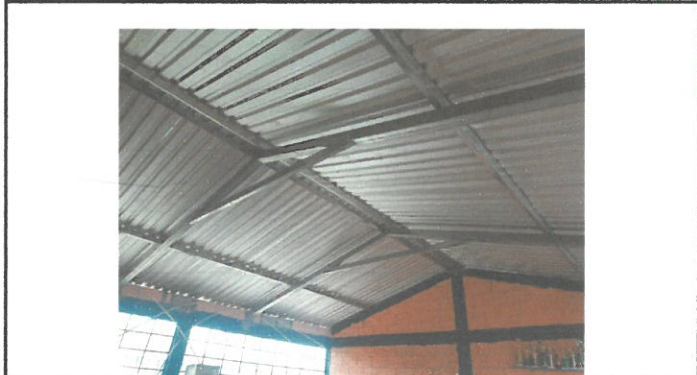
Foto 3: Vista inferior e interior de techo instalado.
