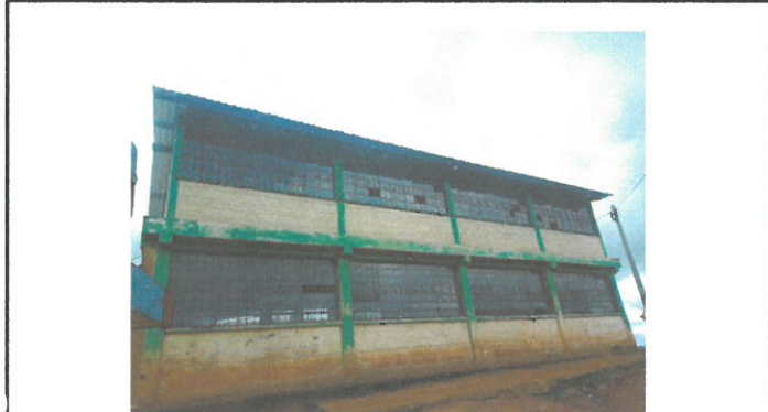
Foto 1: Vista posterior del establecimiento con techo sustituido y balcones colocados en ventanas.
