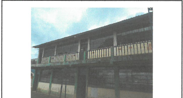
Foto 2: Vista frontal del establecimiento con techo sustituido.
