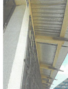
Foto 2: Vista inferior frontal exterior de techo del establecimiento.
