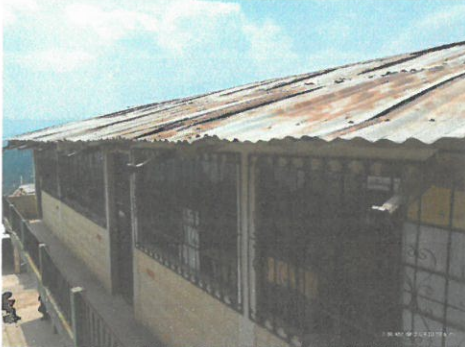
Foto1: Vista frontal superior del techo del establecimiento.
