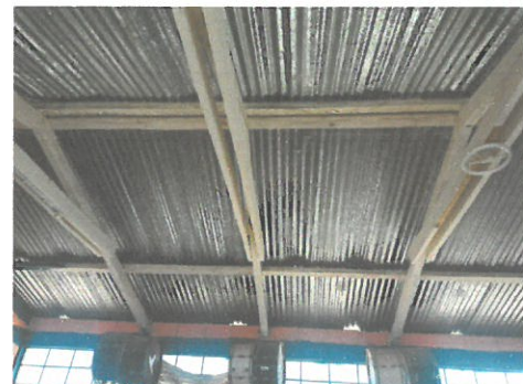
Foto 4: Vistar inferior e interior de techo a sustituir en Dirección del establecimiento.
