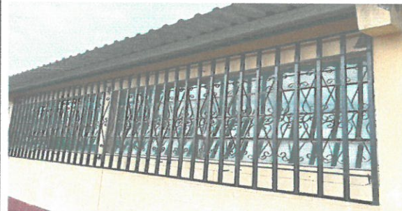
Foto 4: CAMBIO DE VENTANAS, YA QUE LOS ANTERIORES ESTABÁN ROTOS
