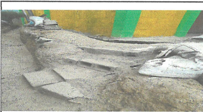
REMOZAMIENTO DE GRADAS
