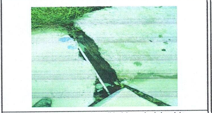
Colocacion de tubos para drenaje y salida del agua hacia la red de drenaje.
