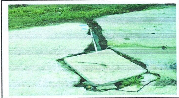
Reparación de depósito y pavimento destruido
