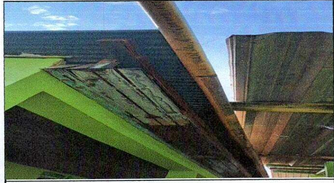
Vista interior de area de techo a remozar.
