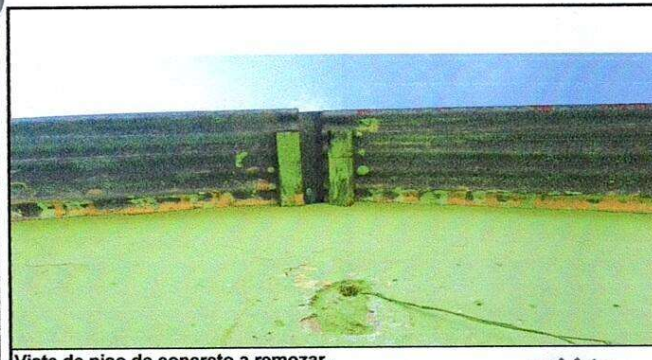
Vista de piso de concreto a remozar.
