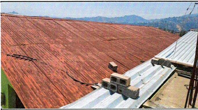
Vista de techo a remozar.
