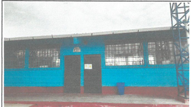
Foto 2: TECHO Y CANALES DE MODULOS TOTALMENTE TEMINADO
