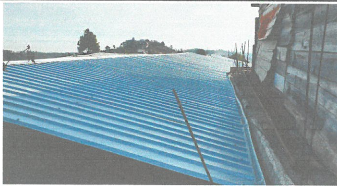
Foto1: TECHO DE CUATRO MODULOS TERMINADO VISTA DE ARRIBA
