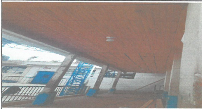
Foto1: MACHIMBRE CORREDOR TOTALMETE TERMINADO
