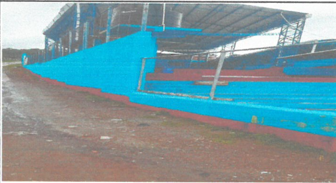
Foto 3: PINTADA EXTERIOR TOTALMENTE TEMINADA
