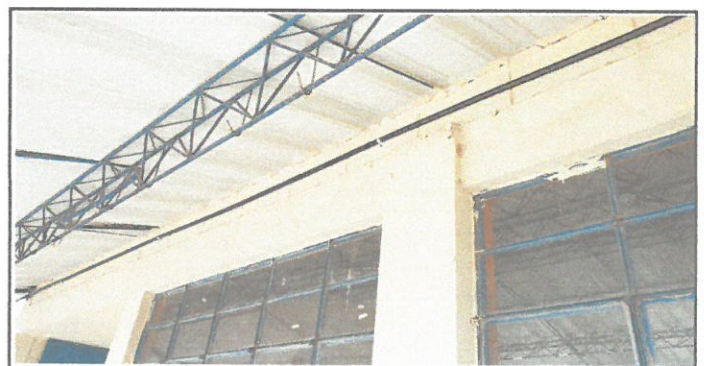
Foto 6: SISTEMA ELCTRICO LÍNEA GENERAL ENTUBADO Y TOTALMENTE TERMINADO
