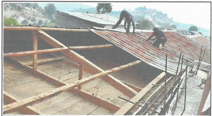
Foto 2: DESENTECHANDO LOS MODULOS A CAMBIAR TECHO
