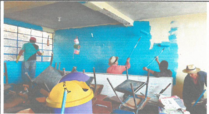
Foto 3: PINTADA INTERIOR DE AULAS
