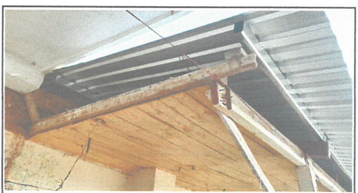
Foto 6: CAMBIO DE MACHIMBRE
