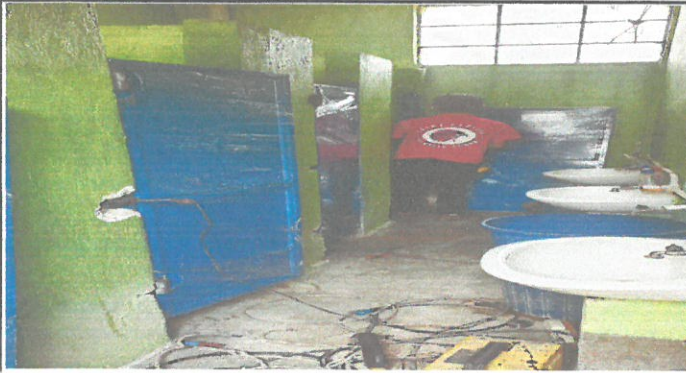
Foto1: Cambio de puertas interiores de baño
