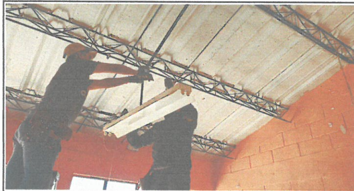
Foto 3: CAMBIO DE LAMPARAS Y LINEAS INTERNAS
