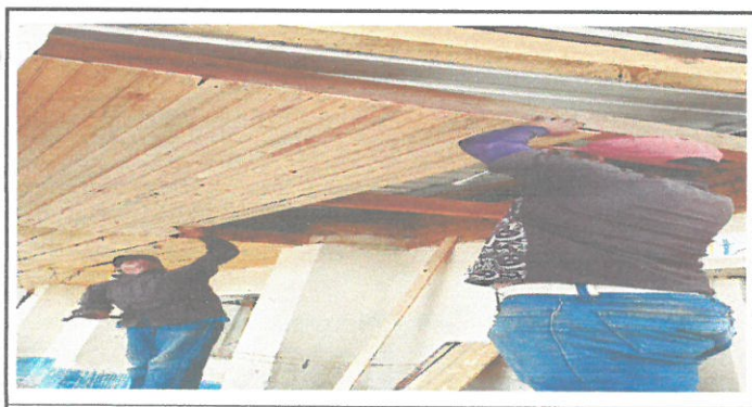
Foto 5: Cambio de machimbre de corredor
