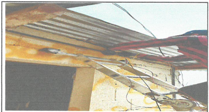
Foto 4: Cambio de línea general de sistema electrico y entubado de la misma
