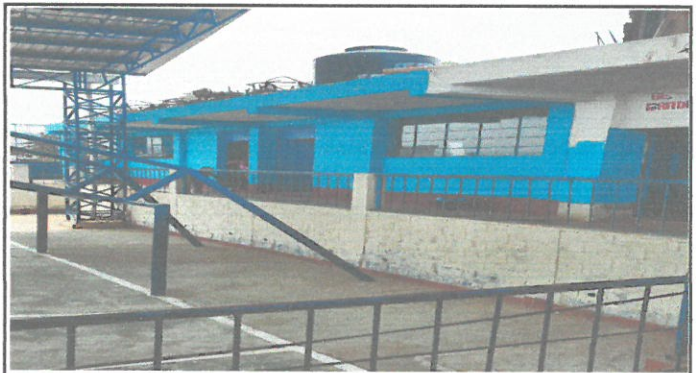
Foto 4: PINTADA EXTERIOR DE AULAS
