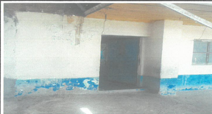
Vista de area de pintura de corredores a remozar.
