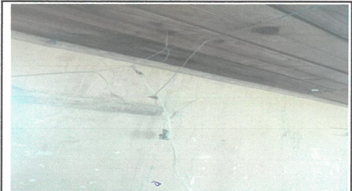
Vista de instalación eléctrica a remozar.
