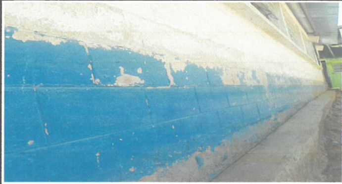
Vista de pintura de paredes a remozar.
