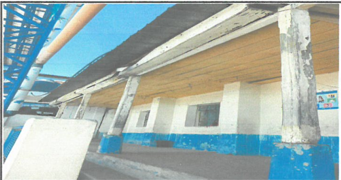
Vista interior de area de techo a remozar.
