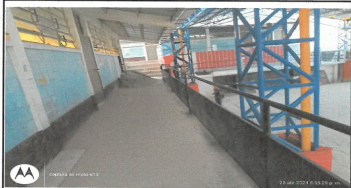
Foto 3: Barandales Instalados frente a Módulo I (renglón 3)
