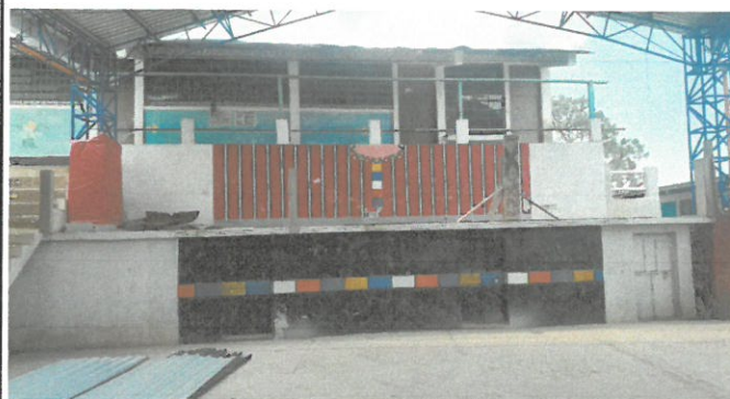
Foto 4: fundición de columnas para barandas. (renglón 4)
