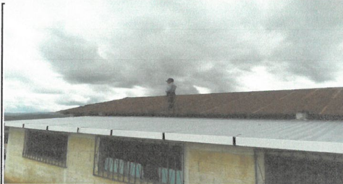
Foto 2: colocación de techo Modulo 2 (renglón 2)
