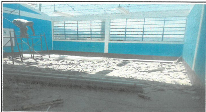
Foto 1: Desinstalación del techo. (renglón 1)
