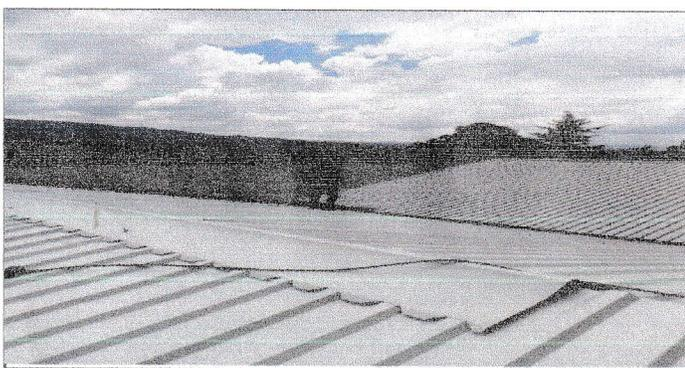
Foto 5: Techo con lamina troquelada del nivel preprimario
