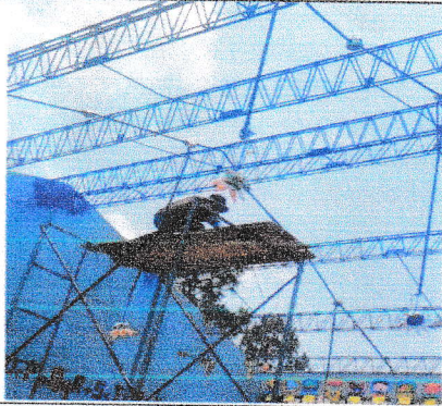
Foto 1: Sustitución de techo de fibrocemento con lámina troquelada.
