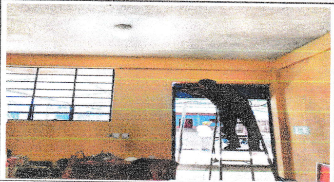
Foto 2: Reparación de pin de puerta con soldadura, en aula de tercero
