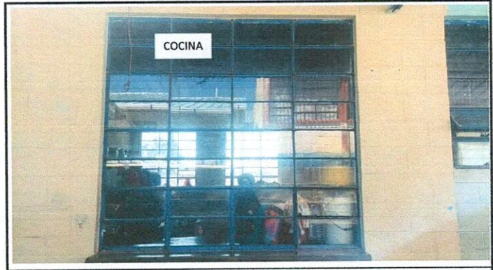
Vista de los ventanales de la cocina donde se instalarán valcones
