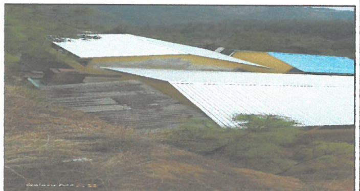
Foto 4: CULMINACION DEL ENTECHADO LA FECHA 10 DE ABRIL DE 2024
