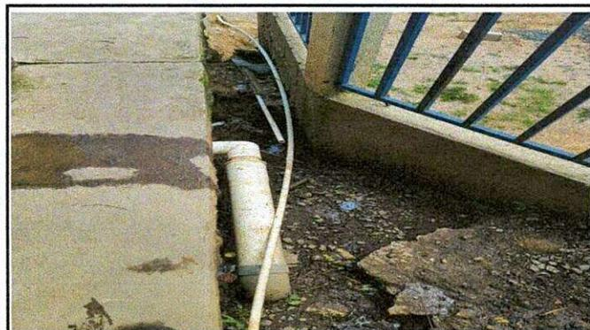
Foto 9: Sustitución de tubería pvc línea principal
