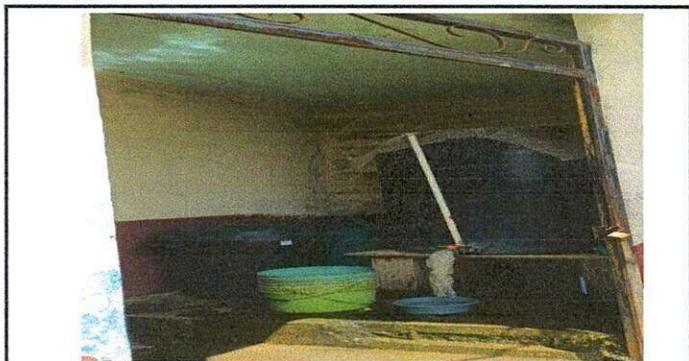
Foto 6: Sustitución de accesorios deposito de agua ( cambio de posición del rotoplas del suelo hacia arriba)
