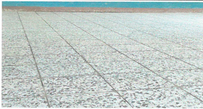
VISTA DEL PISO COLOCADO DENTRO DEL AULA
