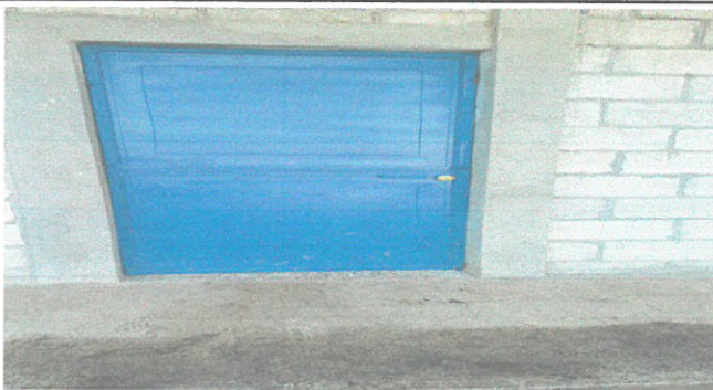
VISTA DE LA BANQUETA REALIZADA
