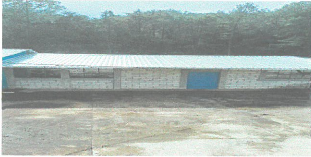
VISTA DEL AULA TERMINANDA
