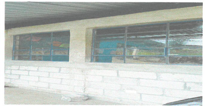
VISTA DE LAS VENTANAS COLOCADAS
