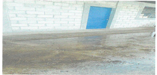
VISTA DE LA PUERTA DEL AULA
