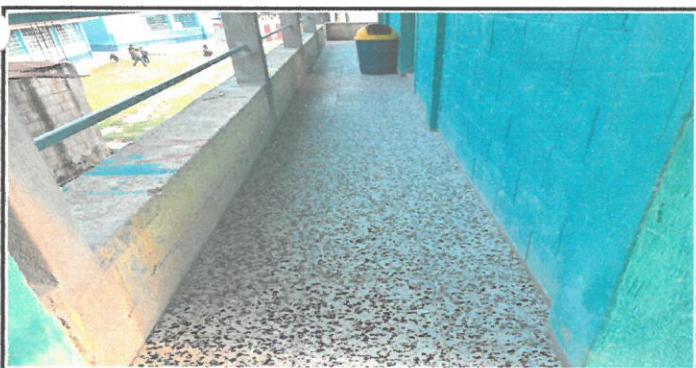
Foto 5: Sustitución de piso de cemento por piso de granito lustrado, corredor en el segundo nivel.
