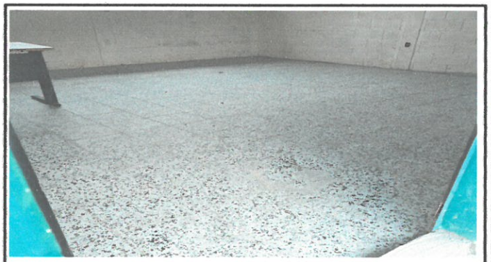
Foto 4: Sustitución de piso de cemento por piso de granito lustrado, aula de dirección.
