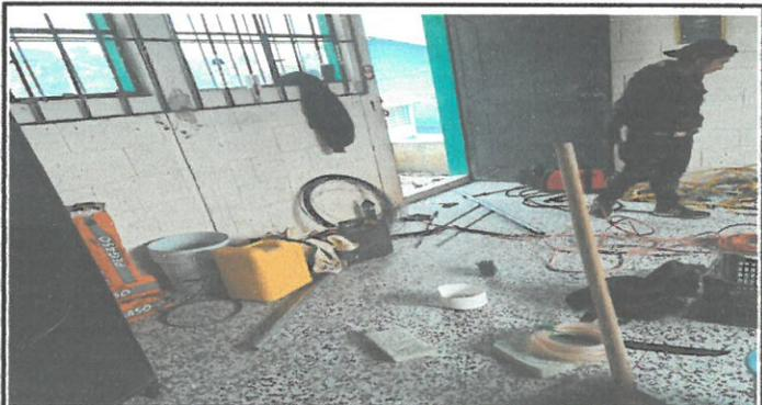
Foto 3: Sustitución de piso de cemento por piso de granito lustrado, aula de 3ero. Básico.
