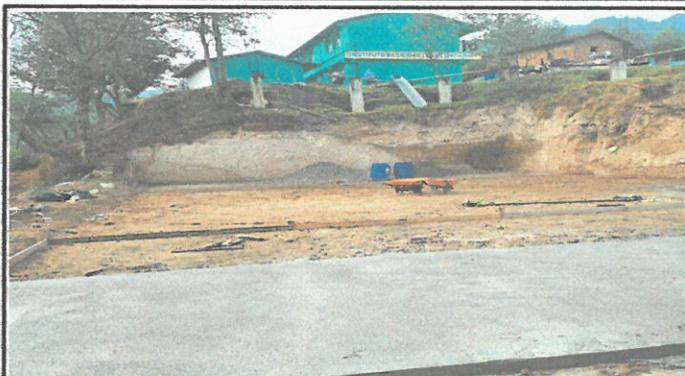
Foto 2: Remozamiento de patio con concreto de 10cm de espesor.
