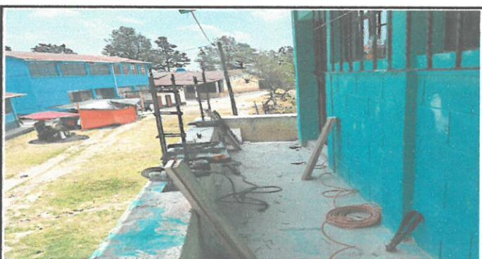
Foto 6: Remozamiento de baranda en el segundo nivel, columnas de concreto y tubos galvanizados.
