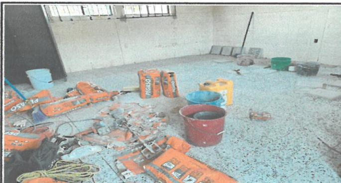
Foto 4: Sustitución de piso de cemento por piso de granito lustrado, aula de dirección.
