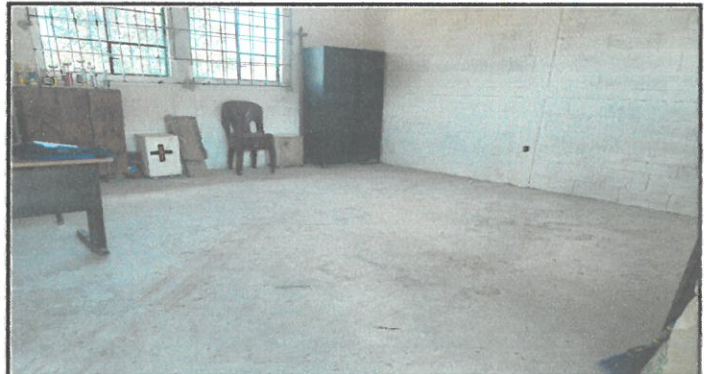
Foto 4: Sustitución de piso de cemento por piso de granito lustrado, aula de dirección.
