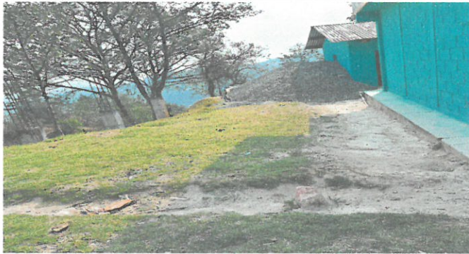
Foto 1: Remozamiento piso de tierra alrededor del INEBT con concreto de 10cm de espesor.
