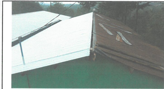
Foto 1: sustitución de laminas de dos aulas
