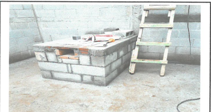
Foto 4: construcción de estufa rural e instalación de plancha
