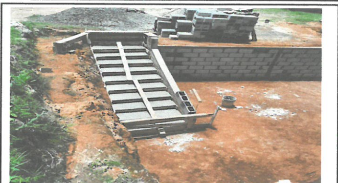
Foto 2: construcción de gradas para acceder al establecimiento
