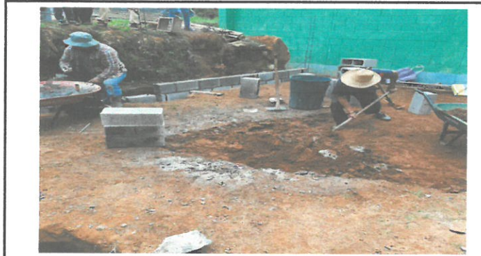
Foto 3: construcción de un muros perimetral de block
