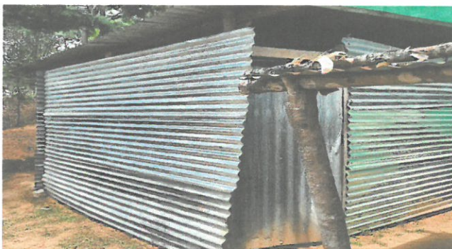
Foto 5: sustitución de las paredes de la cocina de lámina por block e instalación de piso de granito y una puerta de metal
