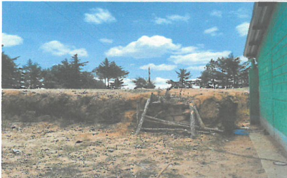
Foto 3: realización de una pared perimetral de block, para evitar que se continúe desbordando el borde
