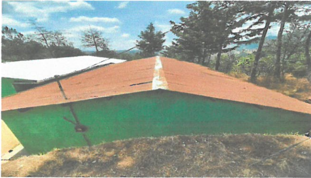
Foto 1: cambio de la lámina de dos aulas, por lamina troquelada
