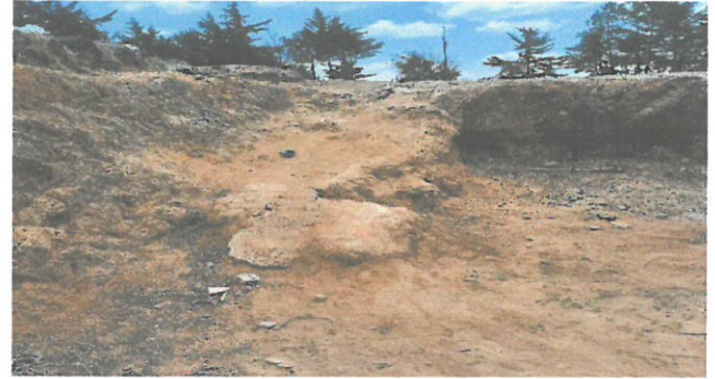
Foto 2: Instalación de gradas formales, para evitar accidentes al acceder al centro educativo
