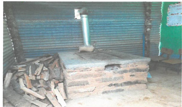
Foto 4: mejora de la estufa rural con la imantación de azulejos, cambio de la plancha por una de metal y sustitución de la chimenea
