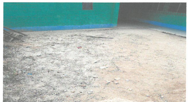
Foto 6: instalación de plancha de concreto en el patio
