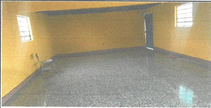
Foto 3: Cambio de piso de cemento por piso de granito y pintura para las paredes
