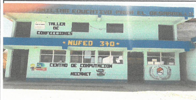
Vista del area con la necesidad de Balcones y Baranda en el segundo nivel
