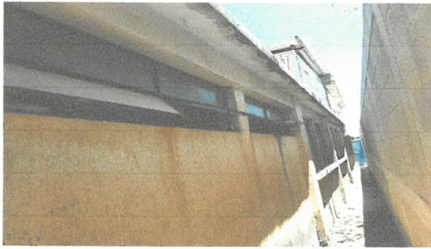
Vista del area con la necesidad de balcones
