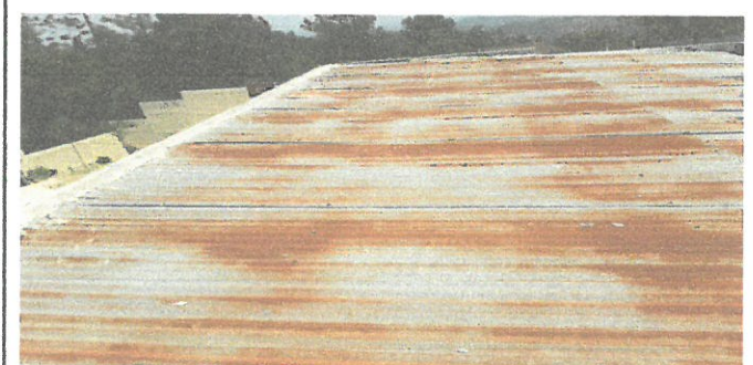
Vista del area donde se necesita el cambio de techo
