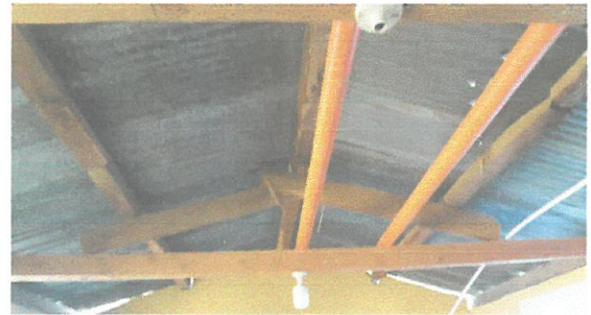
Fotos del techo del aula que necesita cambio de lámina y de estructura
