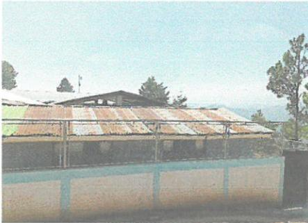
Fotos del techo del aula que necesita cambio de lámina y de estructura
