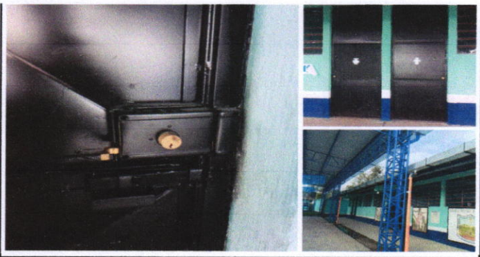
Foto 5: Vista de las puertas de los módulos , se remozó con cambio de 6 chapas de 4 aulas , arreglo y pintura de 11 puertas de aulas, una bodega y una cocina.
