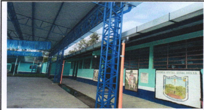
Foto 3: Vista de la parte de enfrente del módulo se remozo con un canal galvanizado de 30 metros con 4 bajadas.
