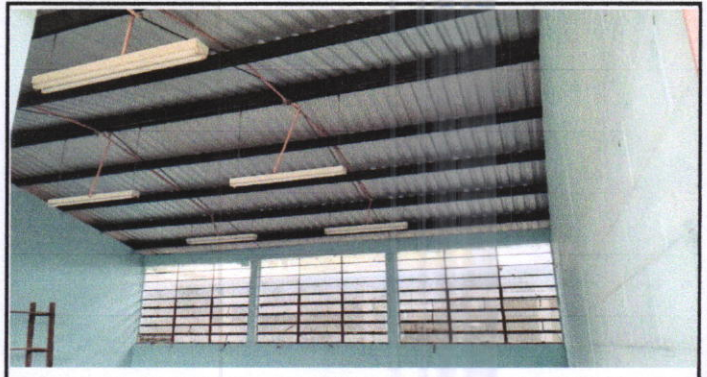
Foto 2: vista de la cubierta de la estructura del techo del módulo de tres aulas y 2 baños , se pintó todas las costaneras y se le dió mantenimiento.
