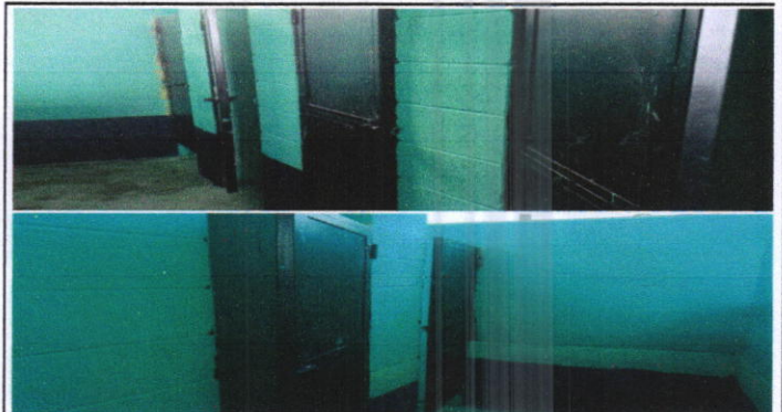
Foto 4: Vista de las puertas de los baños , se remozó con la reparación de las puertas, instalación y pintura de 6 puertas .
