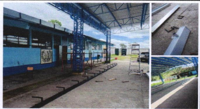
Foto 3: fabricación de canal, soportes y bases para canal galvanizado de 30 metros con 4 bajadas.
