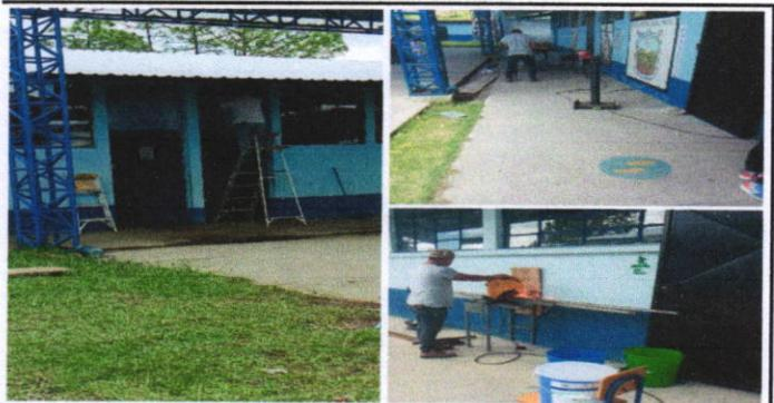
Foto 5: Cambio de 6 chapas, Reparacion 4 de puertas y pintura, de 11 puertas de aulas, una bodega y una cocina.
