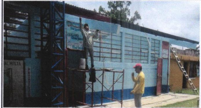
Foto 2: mantenimiento y pintura de costaneras, estructura de techo del módulo 1. que consta de tres aulas y 2 baños.
