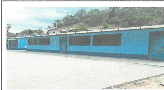
CULMINACION DE PINTADAS DE AULAS.
