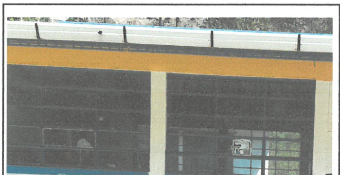
REGLON DE TRABAJO CAMBIOS DE VIDRIOS ANTES DE LA EJECIÓN
