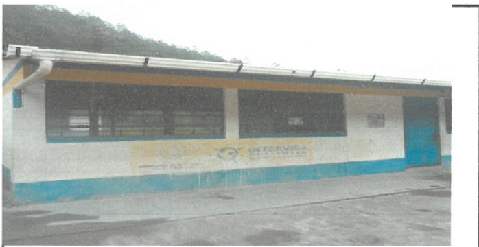
REGLON DE TRABAJO ANTES EN COLOCACION DE BALCONES.
