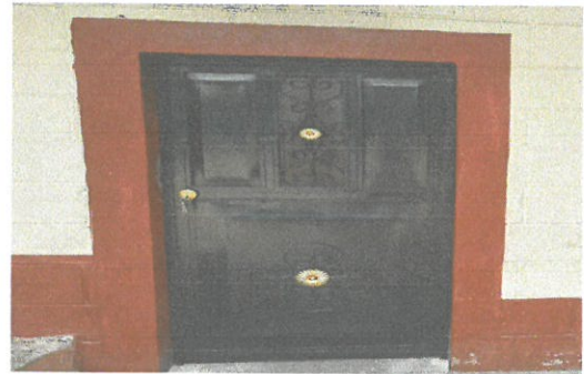
Foto 2: Puerta de cocina
