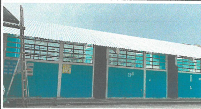
Foto 1: Techado de 3 aulas y 1 bodega
