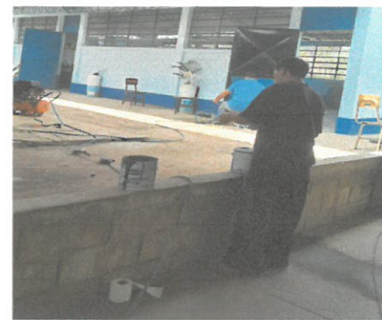
Foto 4: MANTENIMIENTO DE PUERTA
