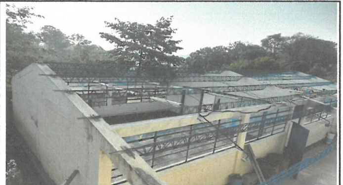
Foto 2: PINTADO DE VIGAS
