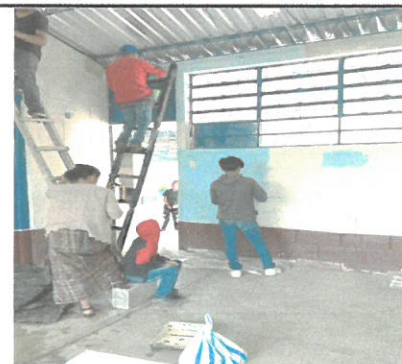
Foto 6: PINTADA DE AULAS
