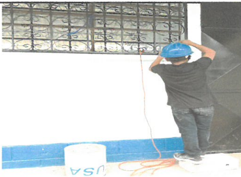
Foto 5: INSTALACIÓN DE BALCONES
