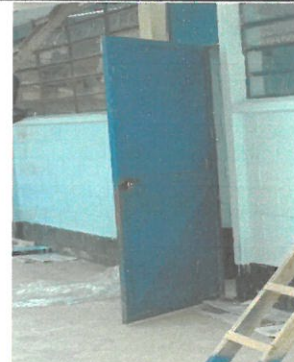
Foto 4: MANTENIMIENTO DE PUERTA
