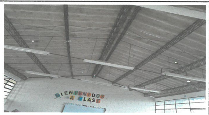
Foto 2: PINTADO DE VIGAS
