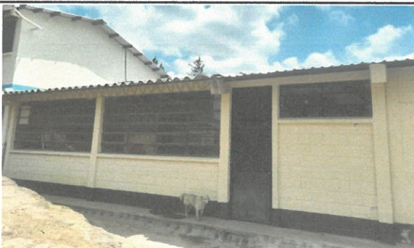
Foto 5: INSTALACIÓN DE BALCONES
