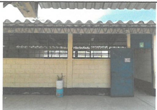
Foto 6: PINTADA DE AULAS
