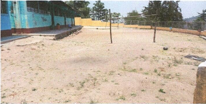
vista del patio de tierra , riesgo para los estudiantes por las piedras que están regadas en el mismo.
