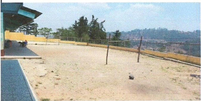
vista de las paredes del muro perimetral a remozar con pintura
