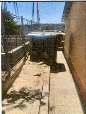
VISTA EXTERNA DE LA SUSTITUCION DE LETRINA A BAÑOS LAVABLES
