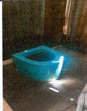
VISTA INTERNA DE LA LETRINA
