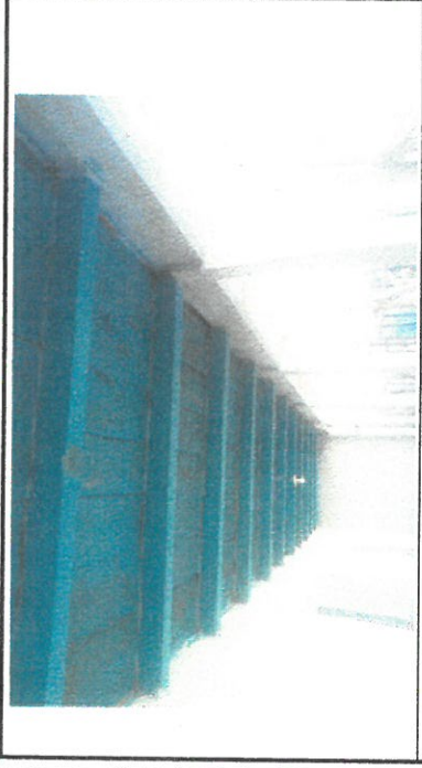
La vigas en el momento cuando se aplicó la primera mano de pintura
