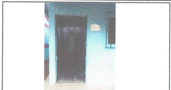
Area de sustitucion de puerta nueva cocina.
