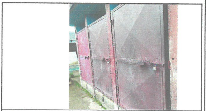
Area de sustitucion de tres puertas nuevas de los servicio sanitario.
