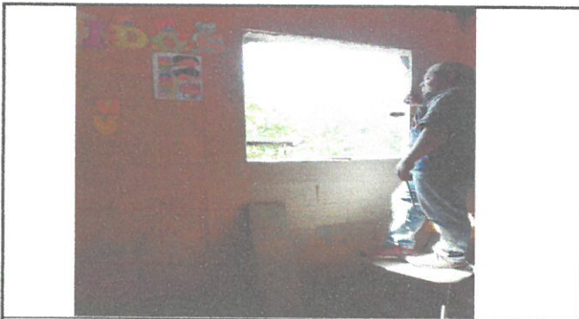
Area de sustitucion de ventana y balcon nueva.
