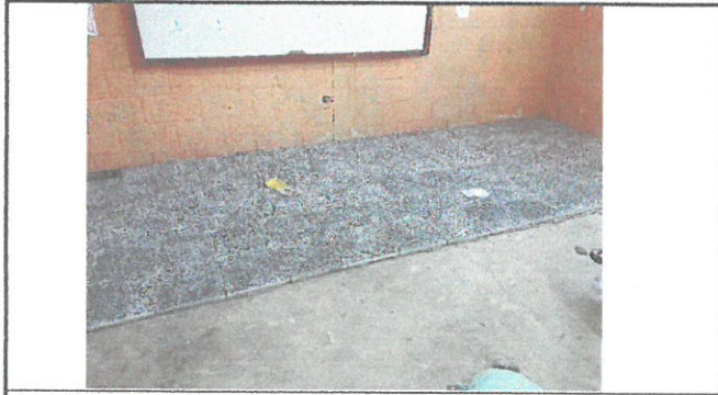
Area donde se instalara piso granito biblioteca
