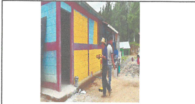
Area de sustitucion de puerta nueva salon 3.
