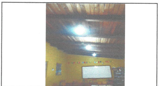
Area de sustitucion por focos LED en todos los salones, bodega, biblioteca y cocina.
