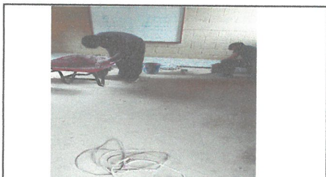
Area donde se instalara piso granito salon 3
