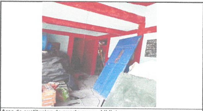
Area de sustitucion de puerta nueva biblioteca.
