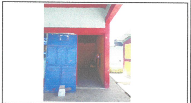
Area de sustitucion de puerta nueva salon 2.
