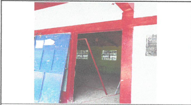
Area de sustitucion de puerta nueva salon 1.
