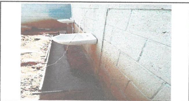
Area de sustitucion de seis lavamanos nuevos incluyendo lozas alrededor de todo.
