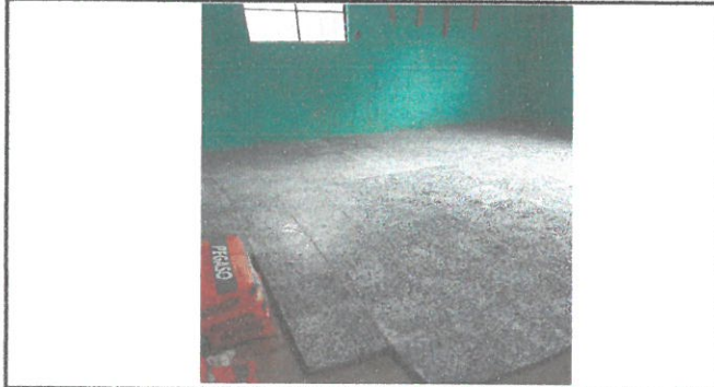
Area donde se instalara piso granito direccion.
