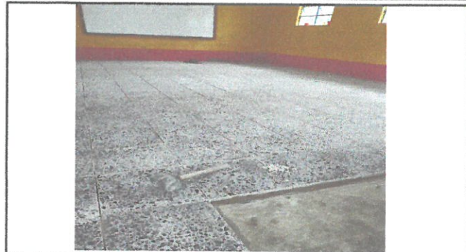
Area donde se instalara piso granito salon 1
