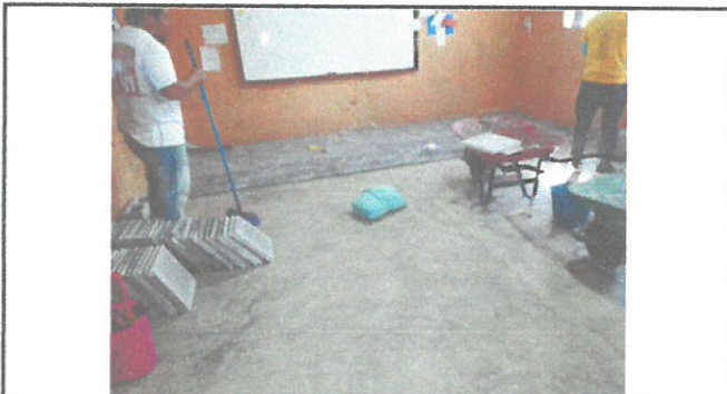
Area donde se instalara piso granito salon 2
