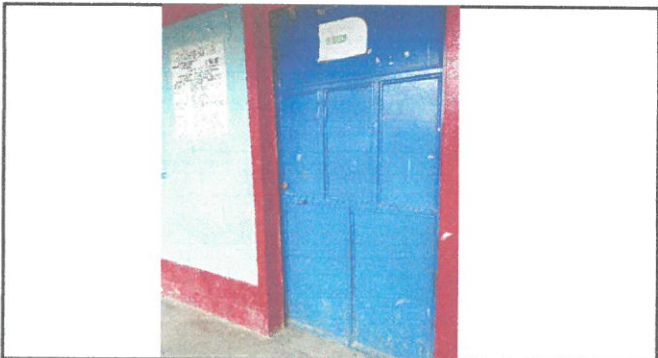
Area de sustitucion de puerta nueva salon 1.
