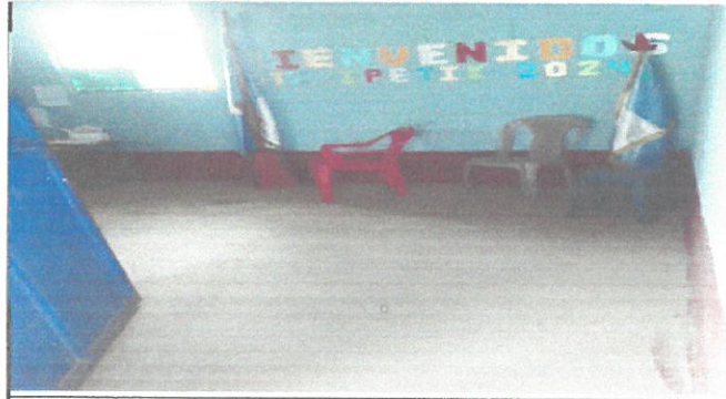
Area donde se instalara piso granito direccion.
