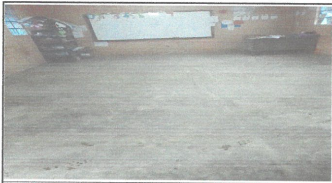
Area donde se instalara piso granito salon 2
