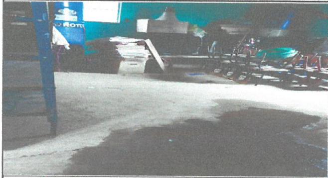
Area donde se instalara piso granito biblioteca
