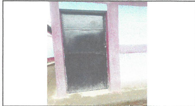
Area de sustitucion de puerta nueva salon 3.
