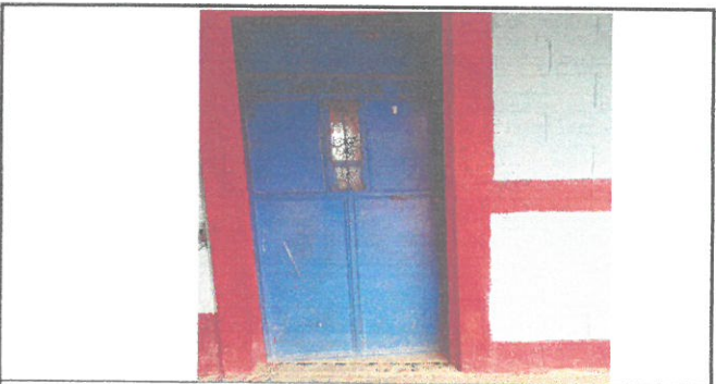
Area de sustitucion de puerta nueva biblioteca.
