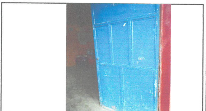
Area de sustitucion de puerta nueva salon 2.
