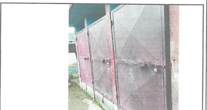
Area de sustitucion de tres puertas nuevas de los servicio sanitario.
