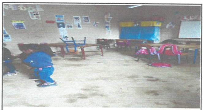
Area donde se instalara piso granito salon 3
