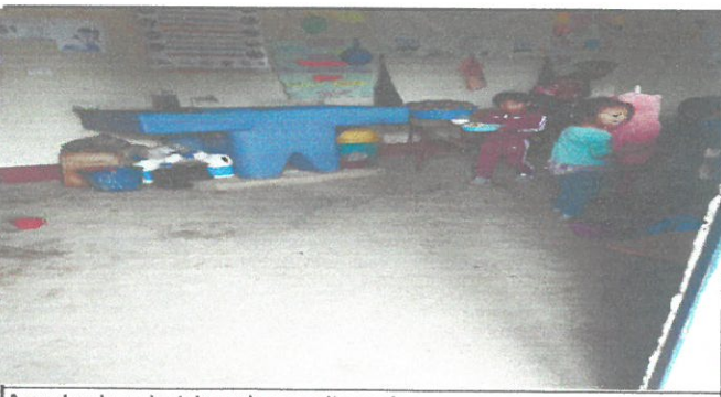
Area donde se instalara piso granito cocina
