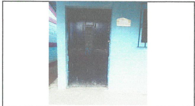
Area de sustitucion de puerta nueva cocina.
