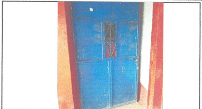
Area de sustitucion de puerta nueva direccion.
