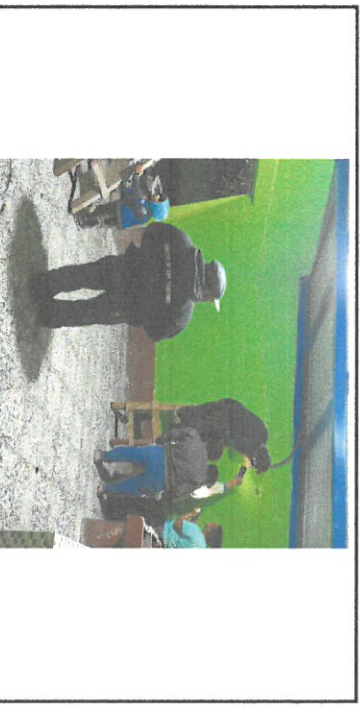
Foto 6: instalación eléctrica en el área de remozamiento, se está sustituyendo cables e instalando lámparas, apagadores y plafoneras
