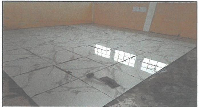
Foto 2: sustitucion de piso del segundo nivel.
